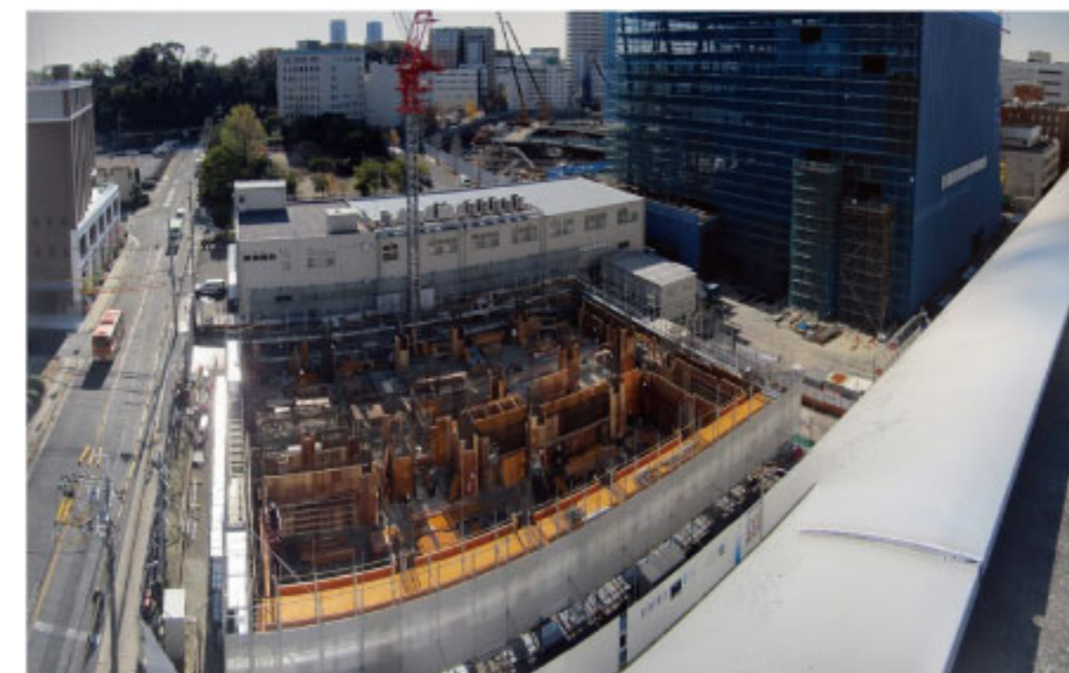
③COM3号館屋上から「駅前再開発地区」を望む(大阪大学学生寮)
